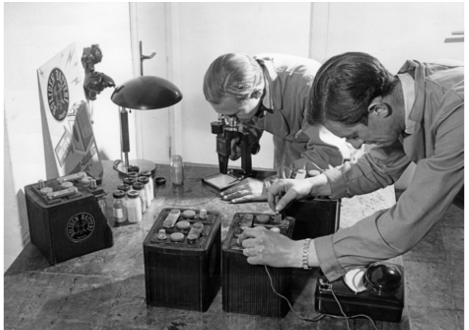
Ingenjör Fogelberg och verkmästare Eriksson i arbete med Bolidenbatteriet.
